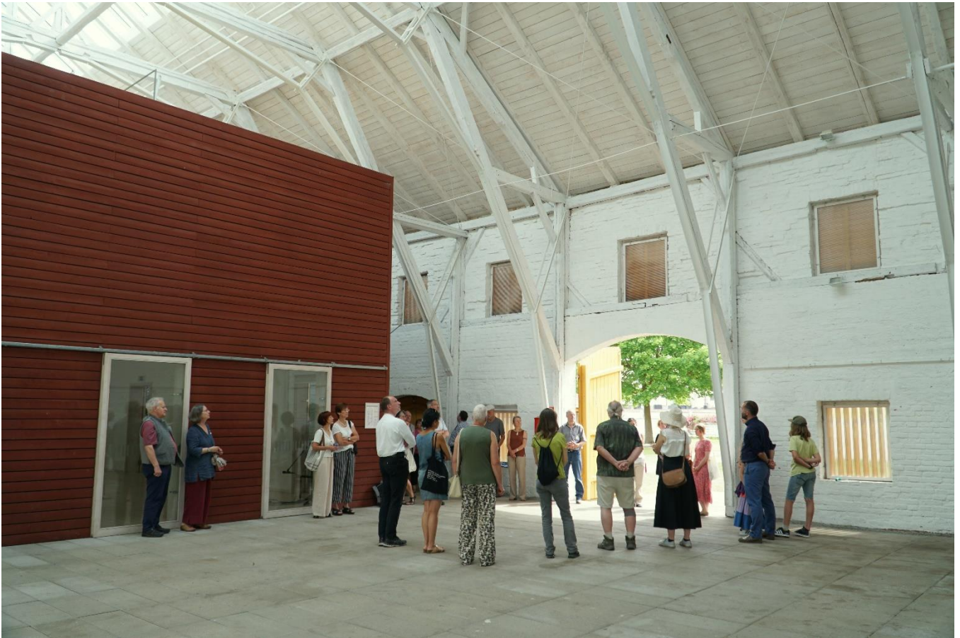
Abbildung 4: Erste Station der Exkursion war der Pfarrstadel in Schwindkirchen bei Dorfen - eine beeindruckende Haus-im-Haus-Konstruktion.
