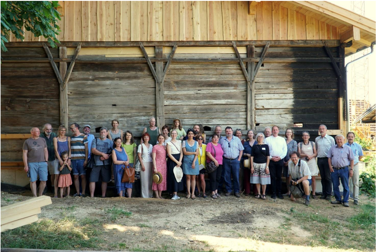
Abbildung 6: Umnutzung eines Stadls aus dem 17. Jahrhundert in Furth zwischen Hebertsfelden und Schönau zu Wohnzwecken - eine beeindruckende Maßnahme, einen denkmalgeschützten Dreiseithof zu erhalten.
